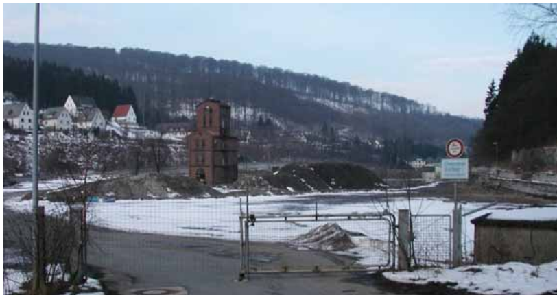
In Revitalisierung befindliche Fläche (Foto: GIH)
