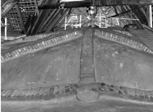
LASERSCANN INTENSITÄTSBILD - GEWÖLBE OBERSEITE CHRISTUSKIRCHE
