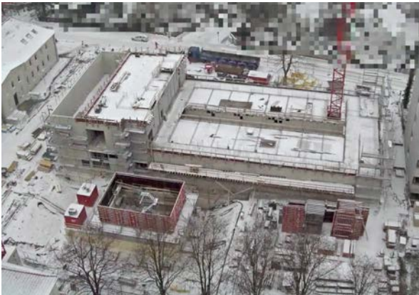
Baustelle des Hannover Institut für Technologie (HITec) in der Callinstrasse im Januar 2016, aufgenommen vom Universitätshochhaus. Im roten Viereck im Vordergrund links entsteht der Einstein-Elevator, ein teilweise im Boden eingelassener Fallturm für Experimente in Mikrogravitation
