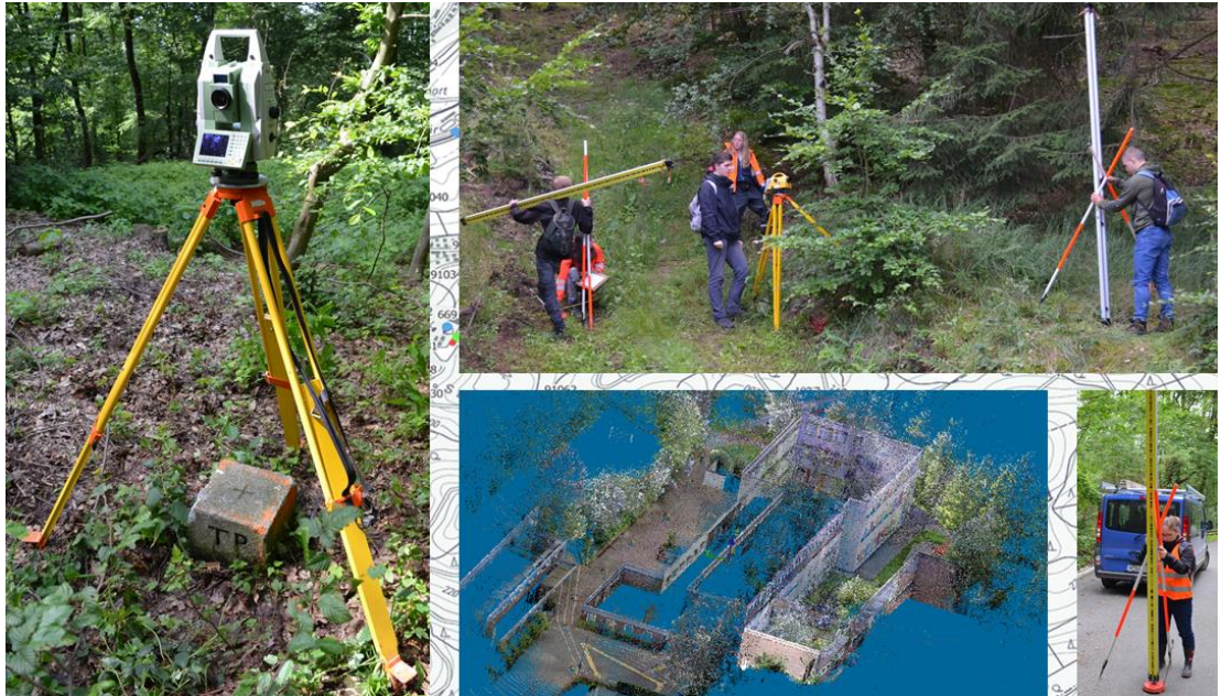
POLYGONZUG ÜBER DEN SAUBERG MIT STANDPUNKT AUF DEM GIPFELPUNKT (LNKS). NIVELLEMENT AM HANG DES SAUBERGES (OBEN UND UNTEN RECHTS). 3D-PUNKTWOLKE DER SOTHENBERGSCHULE (UNTEN MITTE).
