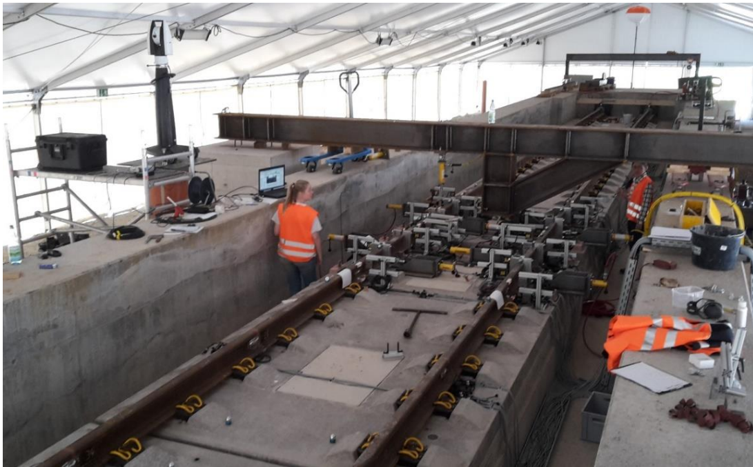
GROßVERSUCH ZUR KNICKSTABILITÄT DER FESTEN FAHRBAHN
