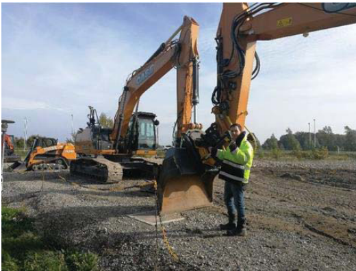
BAGGER MIT MASCHINENSTEUERUNGSSYSTEM
