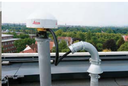
GNSS REFERENZSTATION AUF DEM DACH DES EINSTEIN-ELEVATORS
