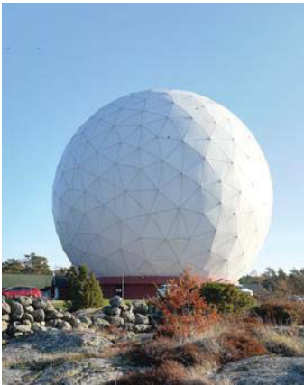
20 M TELESKOP UNTER EINER RADIOWELLEN DURCHLÄSSIGEN SCHUTZSCHICHT (RADOM) VOR UMWELTEINFLÜSSEN. IN BETRIEB SEIT 1976
