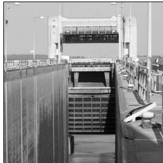
Abb. 1: Innenansicht der Schleuse
