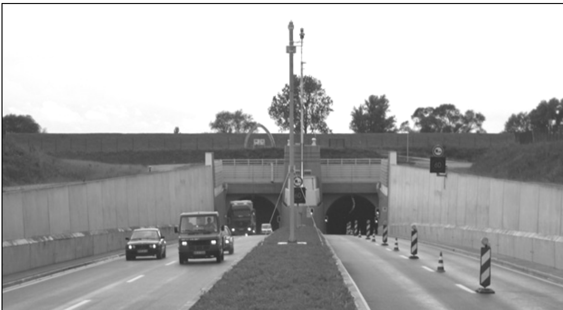
Abb. 1: Einfahrt in den Tunnel bei gesperrter Fahrspur
