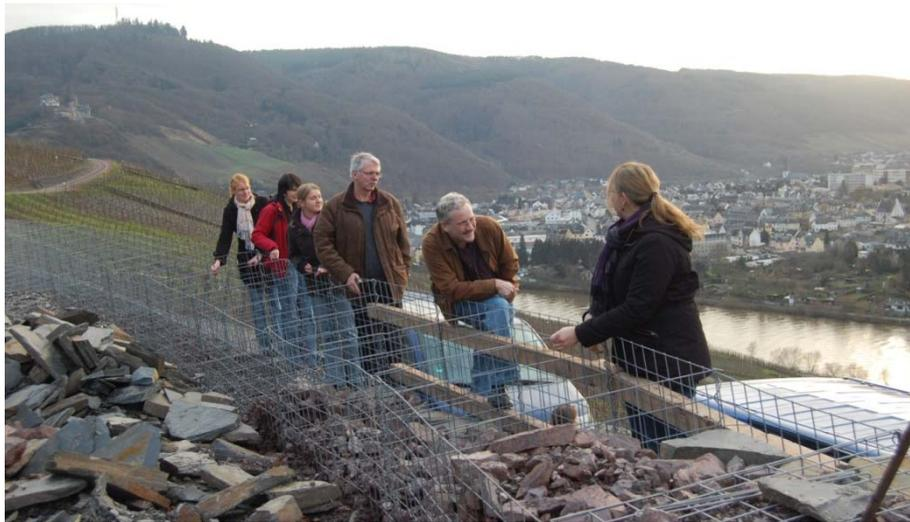
*Gabionenmauer im Bau zur Sicherung der Wege im Steilhang*
