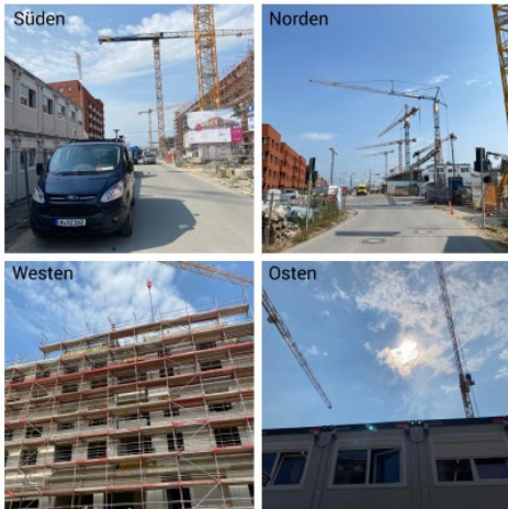
DURCHGEFÜHRTE MESSUNG UNTER HERAUSFORDERNDEN BEDINGUNGEN IN EINEM BAUGEBIET.
